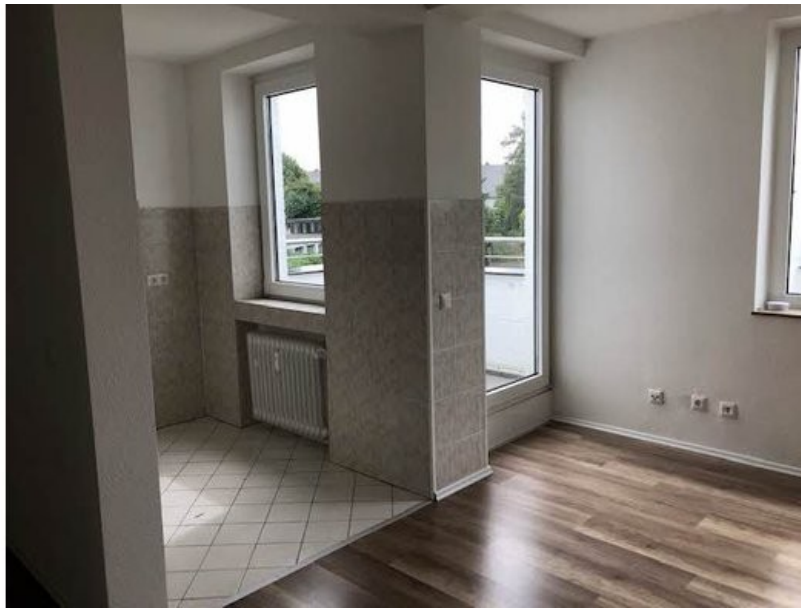
Küche wird noch Eingebaut
